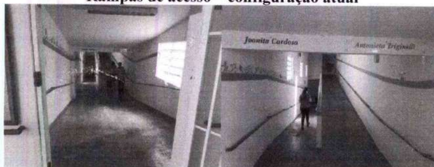
Rampa de acesso ao Coletivo I e Coletivo 2
